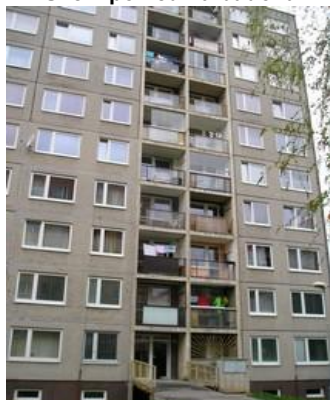
F1 Uliční pohled na budovu
